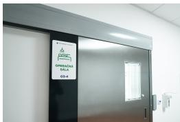
Автоматически раздвижную дверь можно приспособить многим требованиям к входу так, чтобы она могла оптимально выполнять свою функцию, сочетая в себе длительный срок эксплуатации и надёжность. Автоматически раздвижные двери приводятся в движение двигателем переменного тока. Электрический двигатель управляется преобразователем частоты, регулируемым микропроцессором, который безошибочно управляет автоматически раздвижной дверью в любой ситуации, уделяя особое внимание безопасности.
