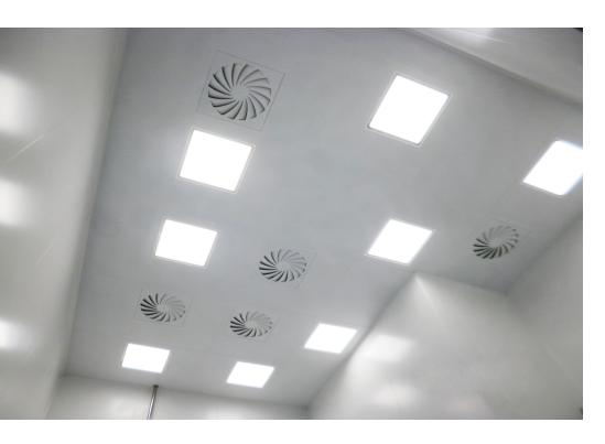
Проходной кассетный подвесной потолок предназначен для устройства подвесных потолков, где предполагается ограниченное движение людей по верхней стороне подвесного потолка при монтаже и сервисных работах.
