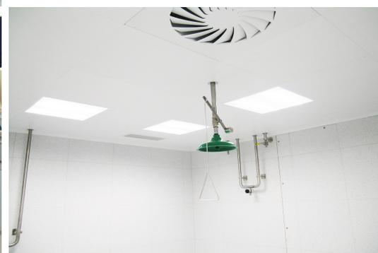
Люминесцентные лампы For Clean Light используется для освещения внутренних помещений с контролируемым классом чистоты. Светильники устанавливаются в лёгкие металлические потолки For Clean и являются воздухонепроницаемыми, обеспечивая тем самым герметичность всего потолка. Конструкция светильника обеспечивает защиту IP 54 в соответствии с EN 60529 (IEC 529).
