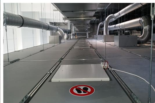
Потолочные кассеты являются частью самонесущей модульной системы, состоящей из алюминиевых несущих профилей и простых металлических кассет или кассет из сэндвич-панели с наполнителем из минерального волокна. Предполагается ограниченное движение людей по верхней стороне подвесного потолка при монтаже и сервисных работах. Для крепления к потолку или несущему растру с помощью нарезных стержней предназначены подвесы, подвесные потолки можно также крепить при помощи стропил.
