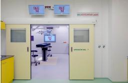
Светильник НЕ ВХОДИТЬ служит для предупреждения лиц, передвигающихся в чистом помещении, о возможной опасности, связанной с входом в определенные рабочие зоны, такие как, например, действие Рентгеновского излучения, или мощного лазера.
