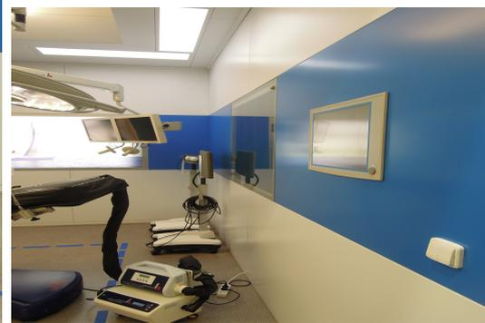
Остекление окна для использования с системой Surgical представляет собой единую, стерильную, герметичную, прочную конструкцию с панелями из нержавеющей стали.
