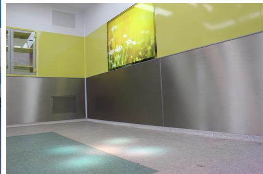
Основные панели Surgical образуют финальную поверхность всей перегородочной системы. Система разделена по горизонтали на три части.
